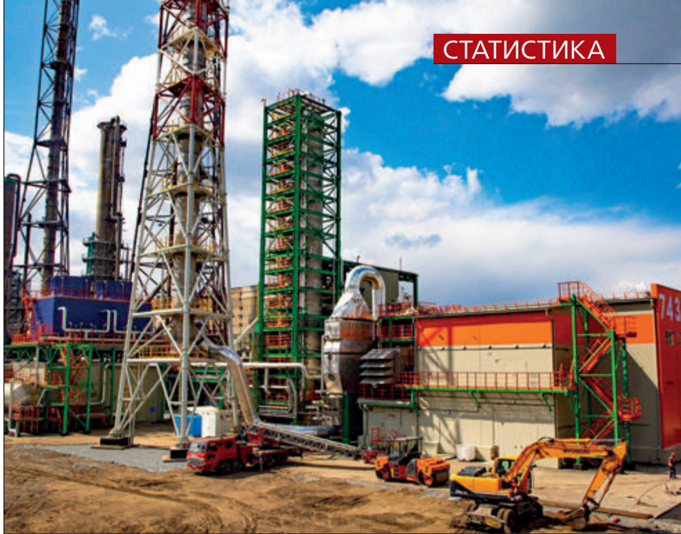
На новой установке по производству азотной кислоты мощностью 500 т моногидрата в сутки «Кемеровского Азота» ведутся пусконаладочные работы.
