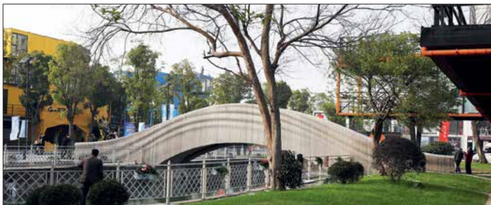
Напечатанный мост соединяет берега канала в одном из парков Шанхая.
