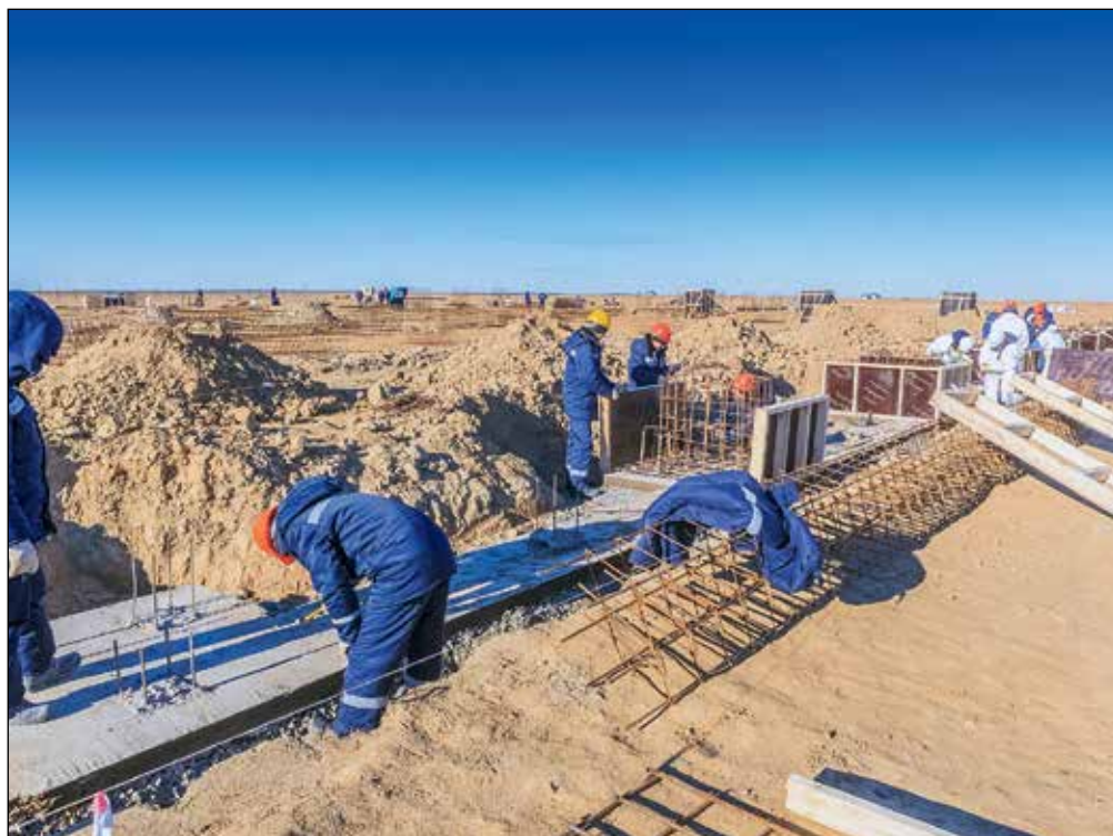
Строительство комплекса в Атырауской области.
