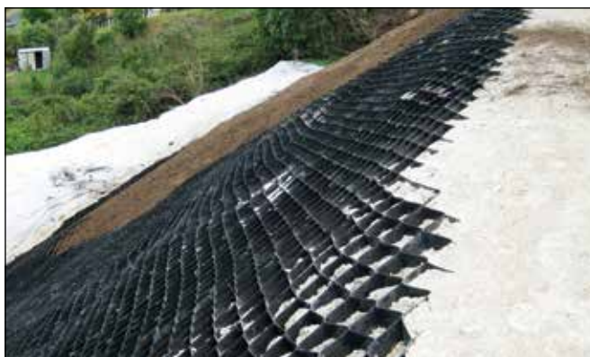
Укрепление склонов георешеткой.
