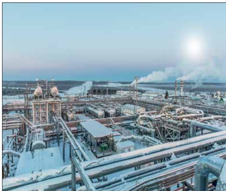
Объекты первого, газового этапа «ИНК» на севере Иркутской области.
