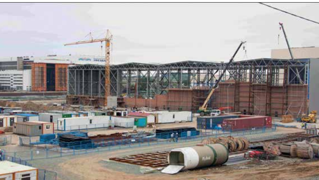
Строительство газохимического комплекса в Находке.
