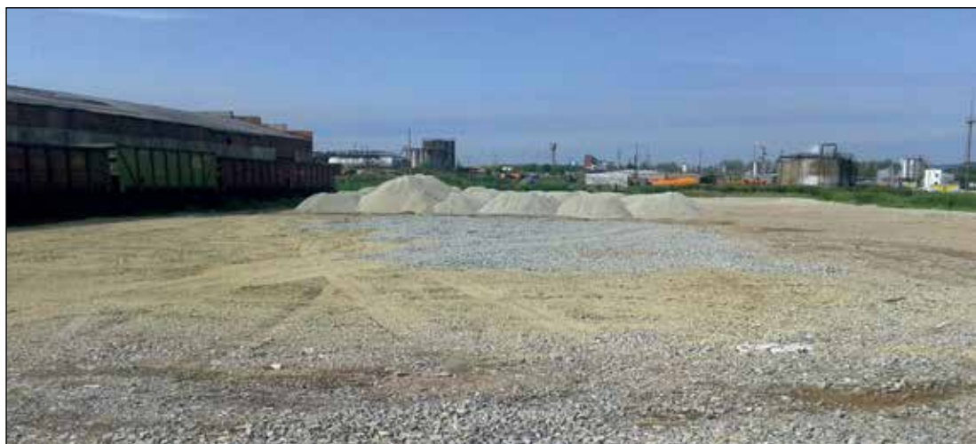
ОАО «Татагрохимсервис». Станция Высокая гора.
