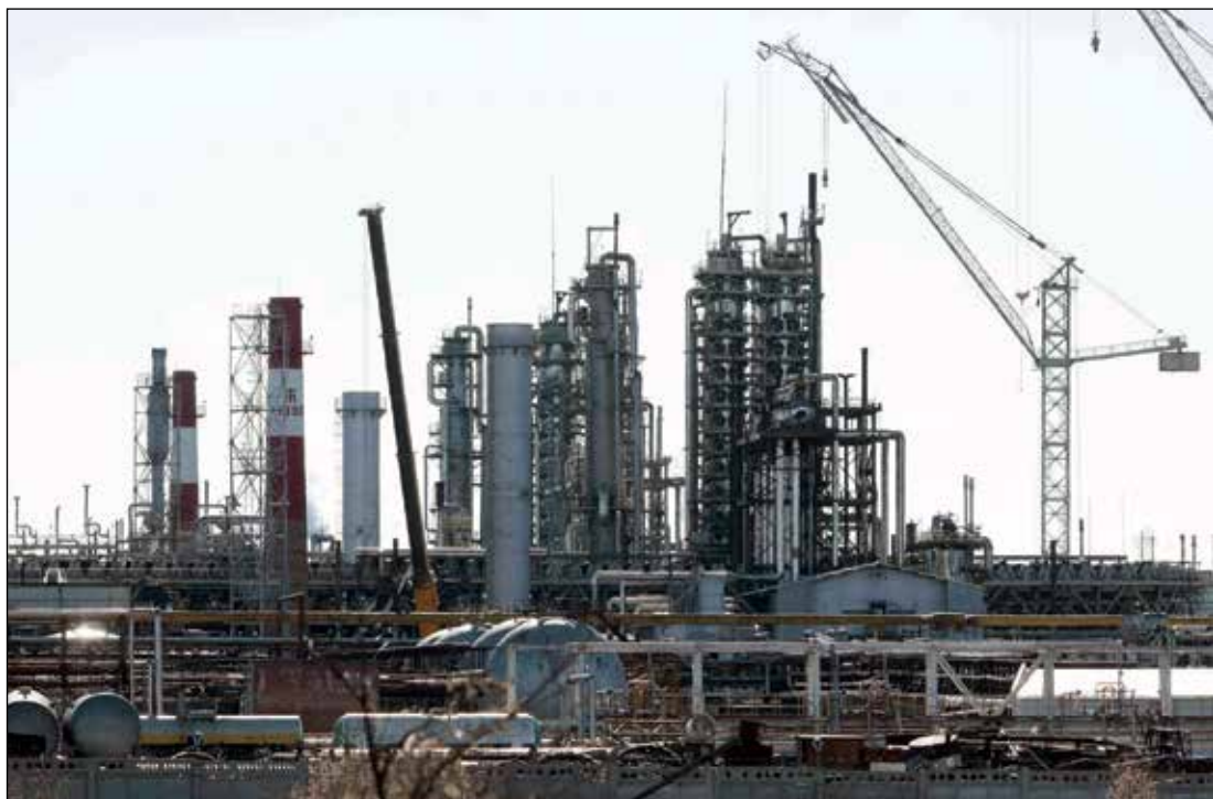
Строительство на производственной площадке «ТОАЗ».
