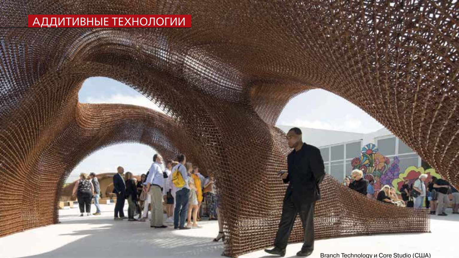
Branch Technology и Core Studio (США) напечатали павильон из углепластика размером 6x13 метров с помощью технологии C-Fab: печать роборукой с рабочей областью до 248 м².
