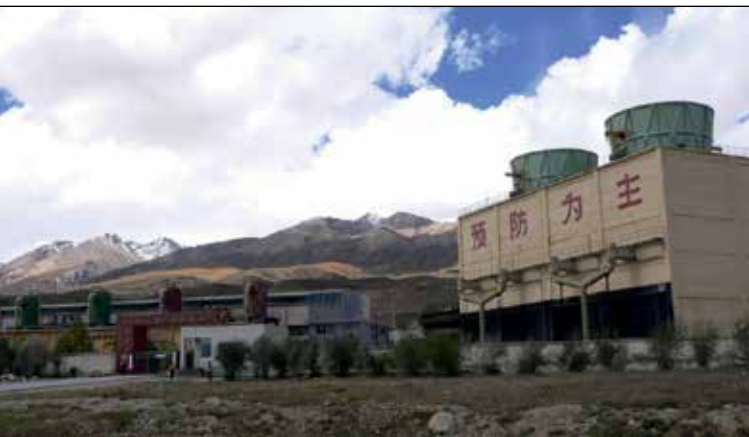
Геотермальная электростанция в Янбаджинге (Китай).
