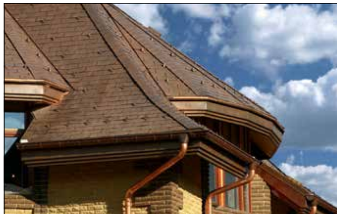
Сейчас изоцианаты, которые используются в кровельной и фасадной теплоизоляции, в основном импортируются.
