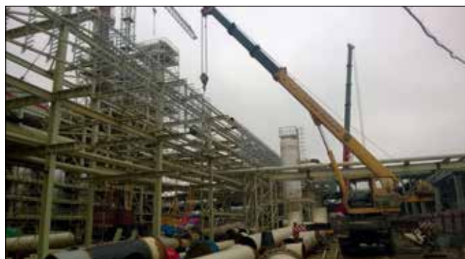
Монтаж технологической эстакады на «Лукойл-Пермнефтеоргсинтезе».
