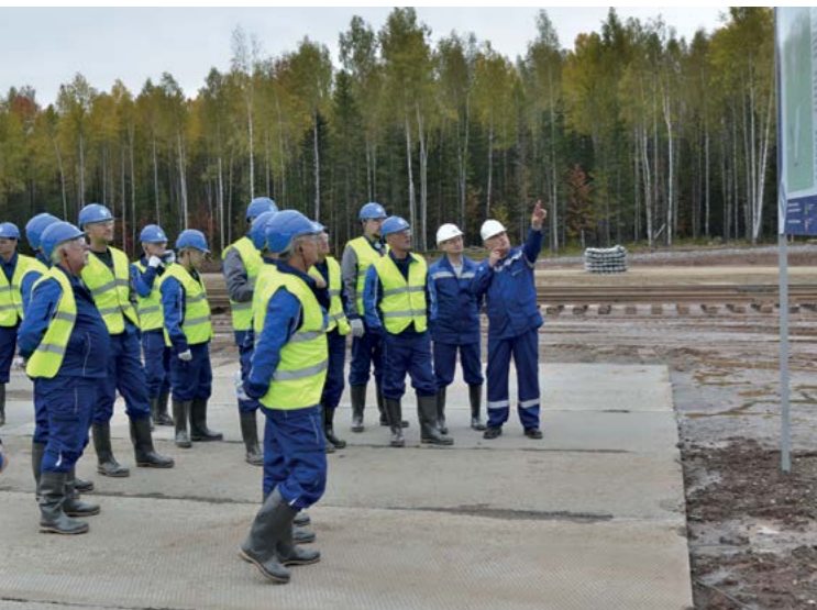
На площадке «Усольского калийного комбината» компании «Еврохим».
