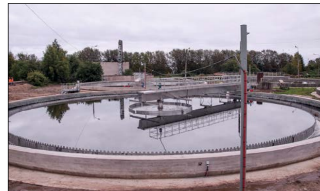
Очистные сооружения в Карелии.
