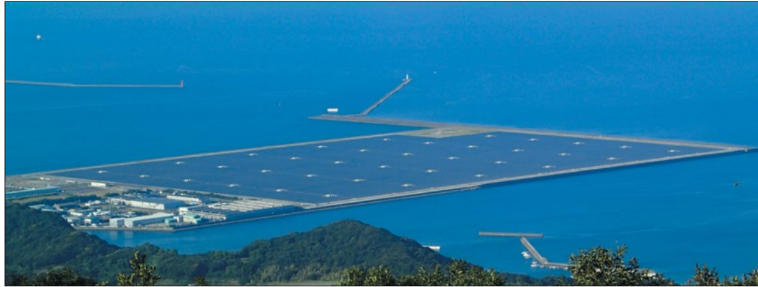
Электростанция в Кагошиме
