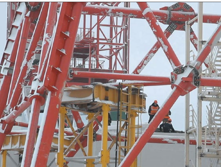
Строительство Усть-Яйвинского рудника
