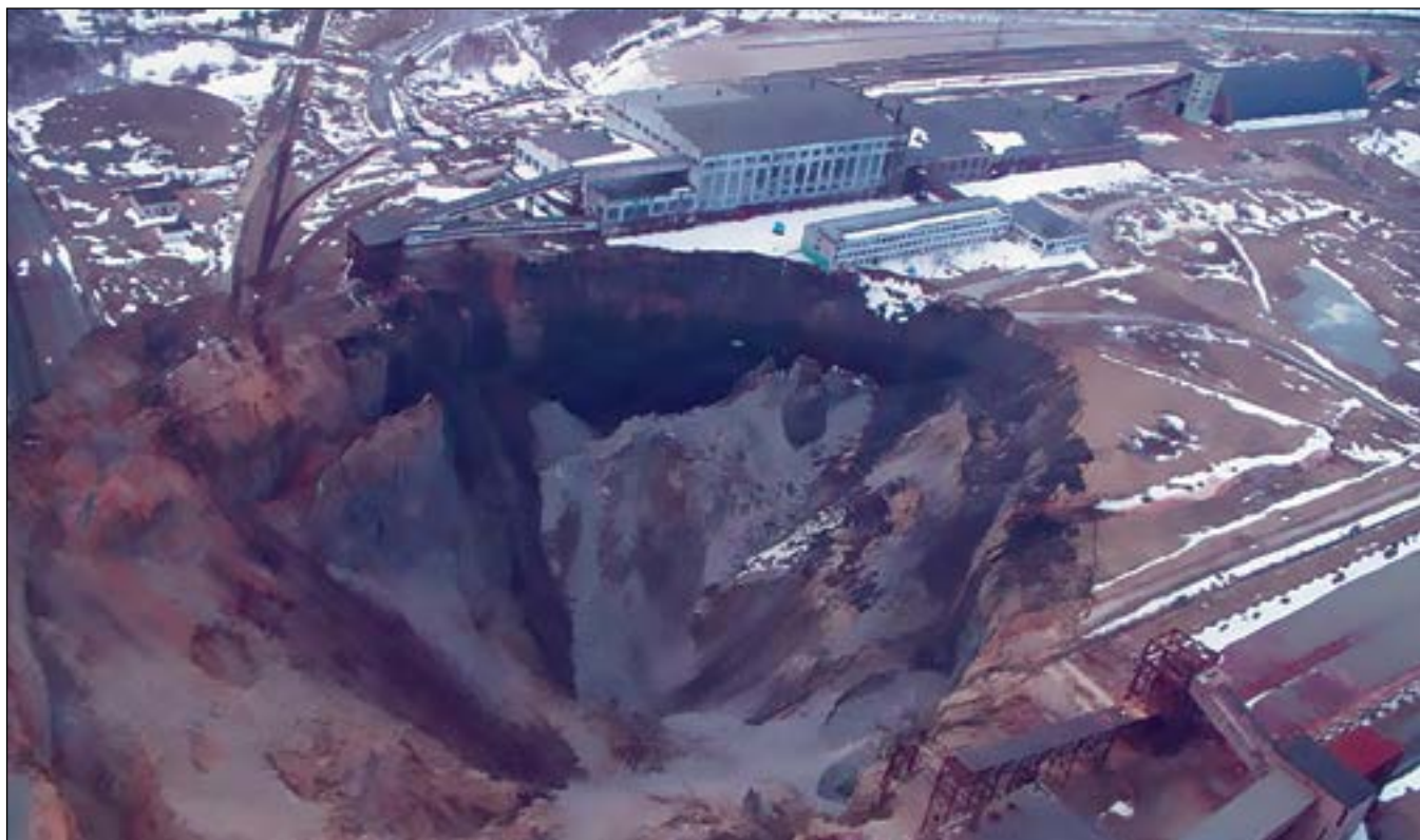
Город Березники построен над калийными шахтами, разработка которых ведется с 1960 года. Из-за отсутствия должных мероприятий по укреплению шахт город постепенно проваливается под землю.
