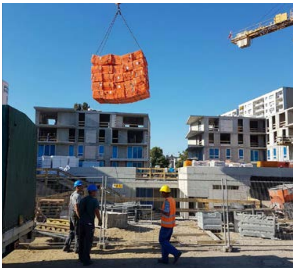
Применение теплоизоляции «Пеноплэкс» на стройке в Польше.
