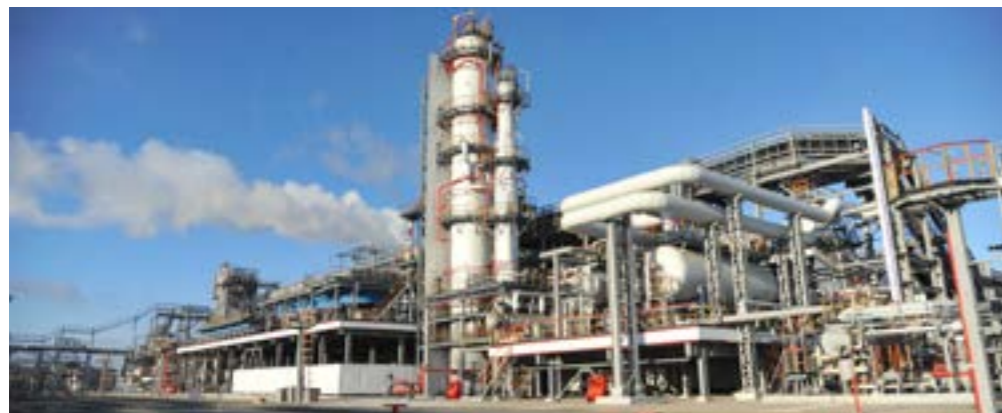
Пилотная установка представляет собой уменьшенную копию комплекса каталитического крекинга.
