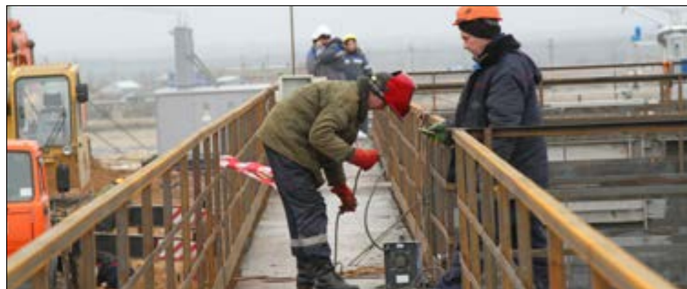
Строительство объектов инфраструктуры по программе освоения Гремячинского месторождения.
