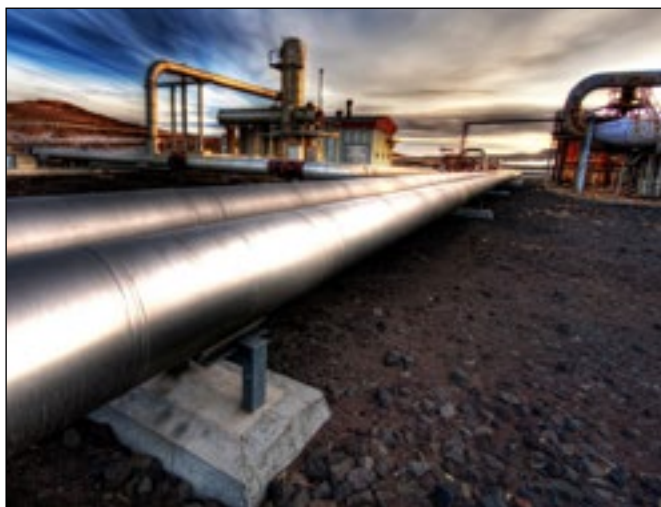
Тема строительства трубопровода обсуждалась Н. Мерлушкиным и В. Путиным 6 июня 2016 года.
