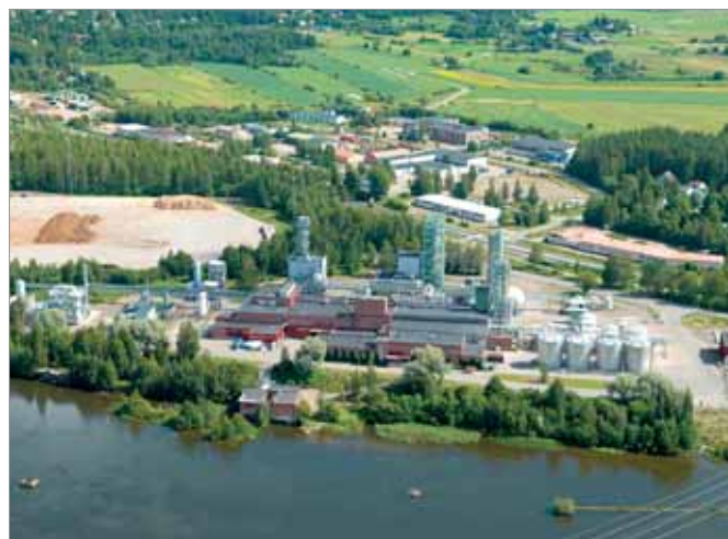
Завод Solvay по выпуску пероксида водорода, г. Войккаа (Финляндия)
