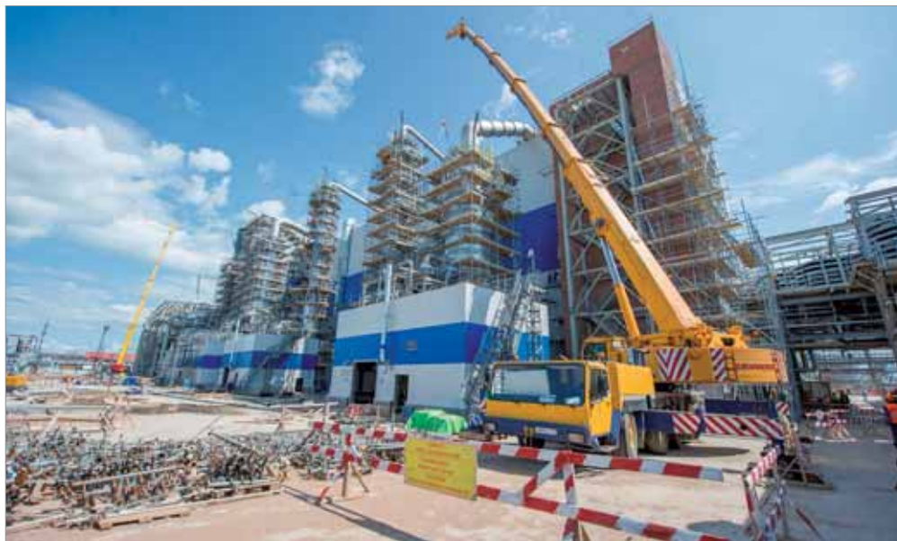
Строительство комплекса акриловой кислоты и акрилатов. Август 2015 года
