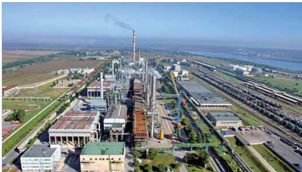
Одесский припортовый завод
