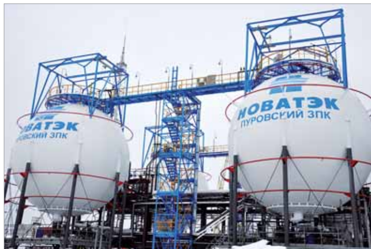
Производство «Новатэк-Пуровский ЗПК», ЯНАО
