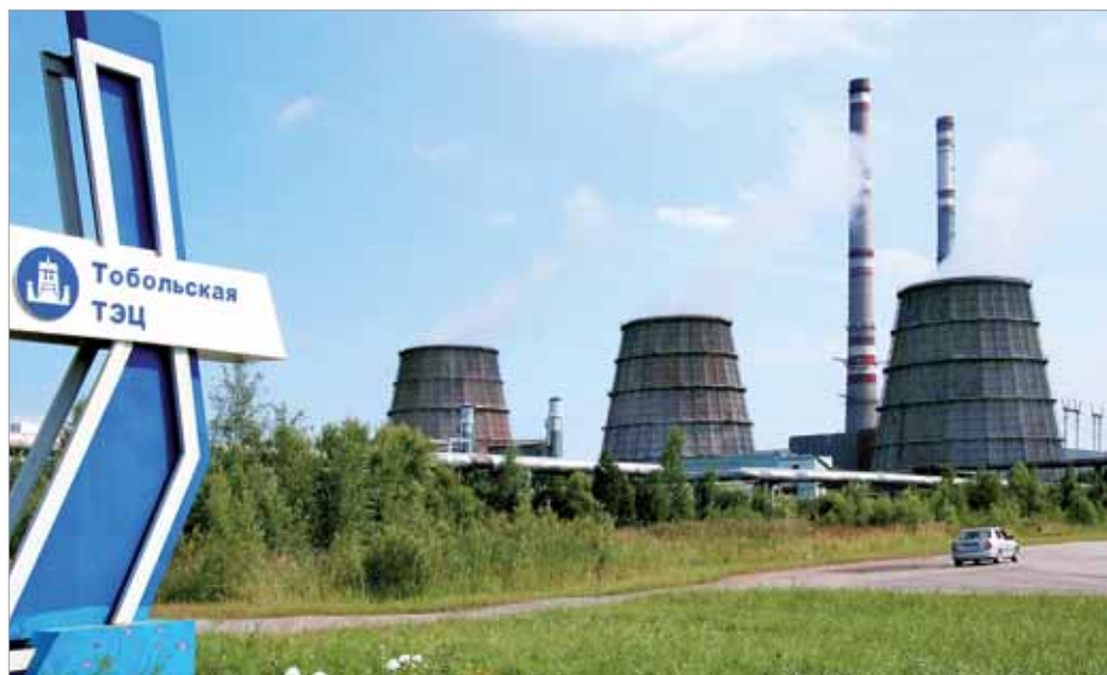
Тобольская ТЭЦ была построена в 1980 году для обеспечения паром Тобольского нефтехимического комбината.
