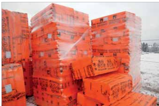
Участок международной трассы E18 в Финляндии возводят с помощью плит компании «Пеноплэкс»
