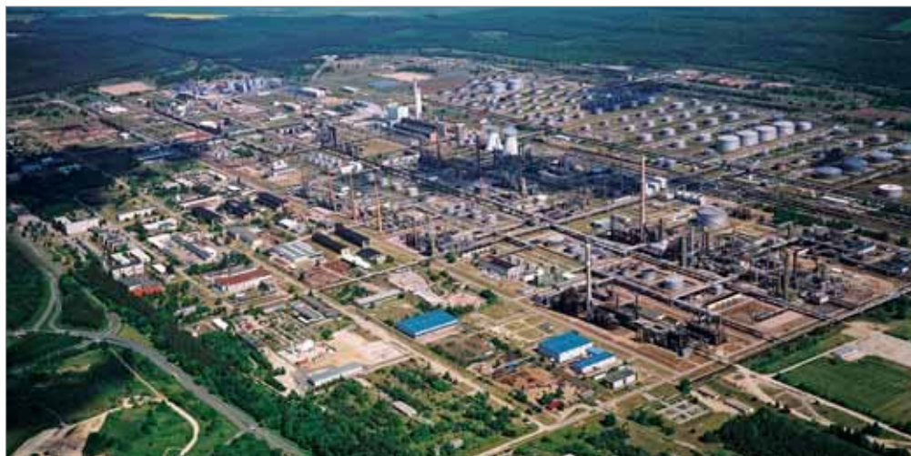
Нефтеперерабатывающий завод PCK Raffinerie GmbH, Шведт (Германия)
