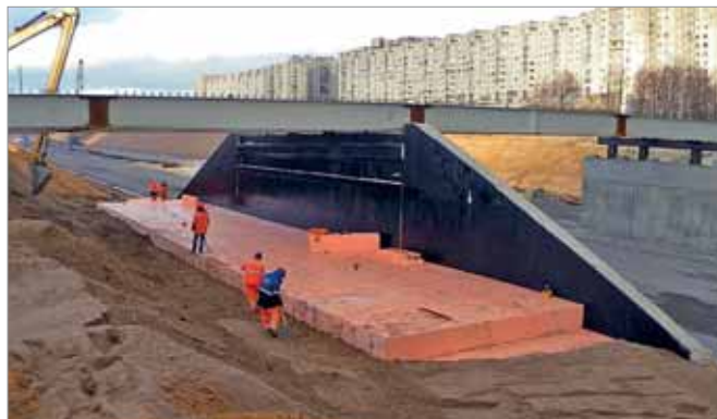
Возведения путепроводов, Санкт-Петербург
