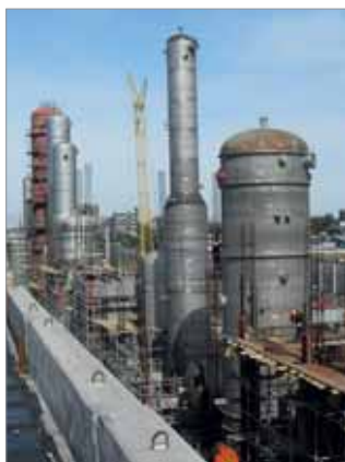
Строительная площадка производства циклогексанона
