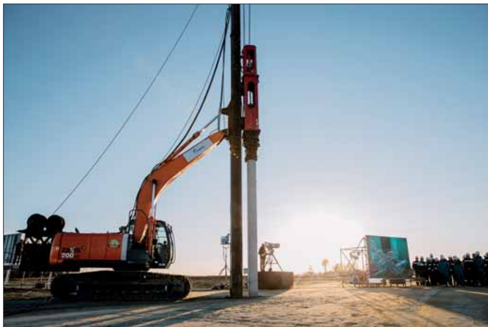
Начало строительства Амурского газоперерабатывающего завода
