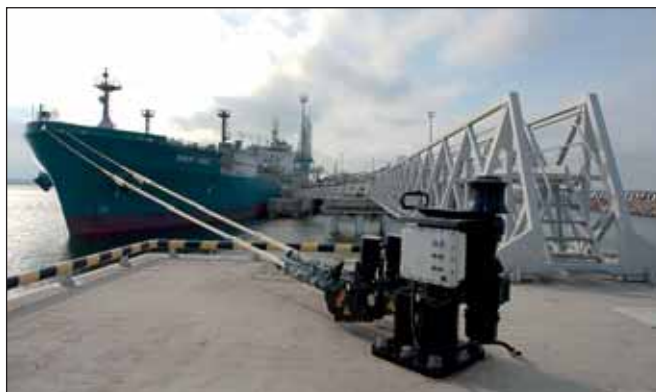
Терминал по перевалке сжиженных углеводородных газов, «Сибур-Портэнерго», Усть-Луга
