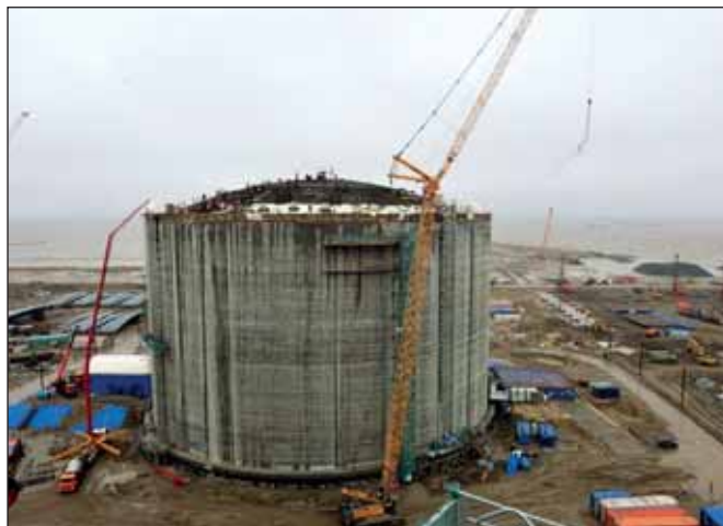
Строительство завода по производству сжиженного природного газа, Ямал
