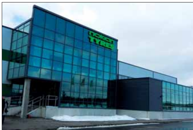
Производство Nokian Tyres, Всеволожск (Ленинградская область)
