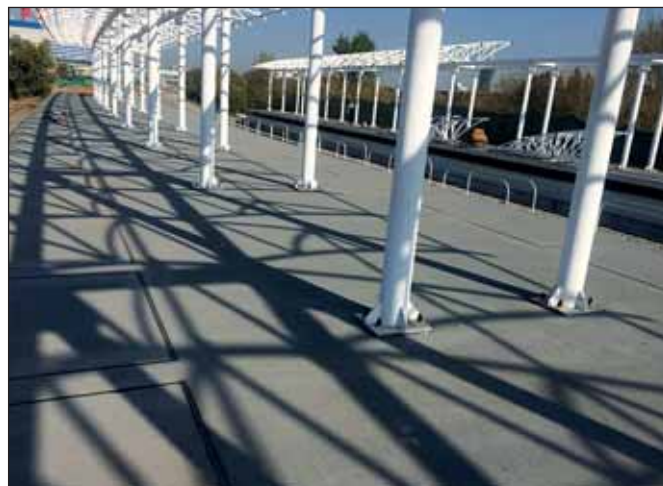
Инновационное покрытие на станции Хорошево позволит значительно снизить возможность образования наледи
