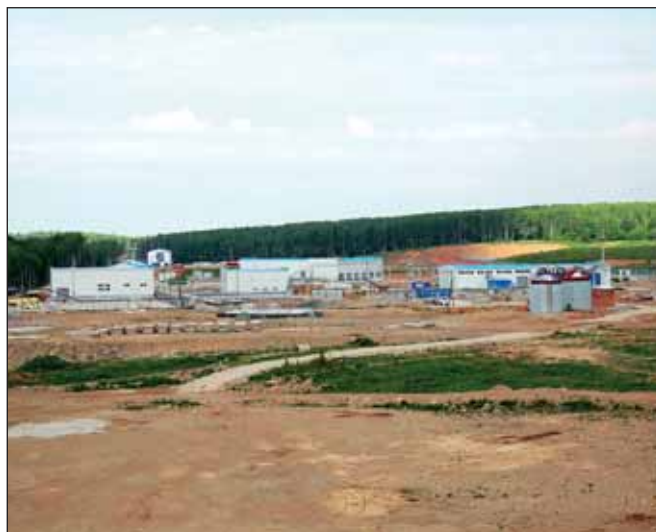
Промплощадка Талицкого ГОКа
