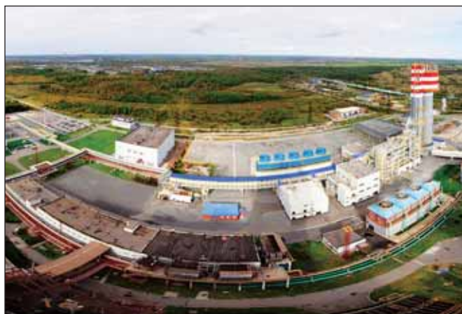
Производственный комплекс АО «Фосагро-Череповец»
