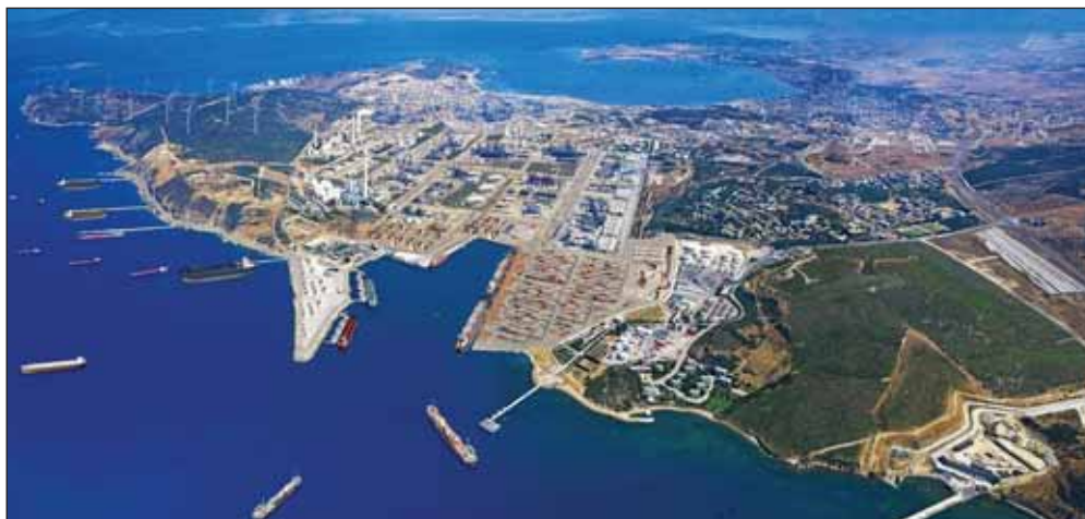
Нефтеперерабатывающий завод Star, Турция
