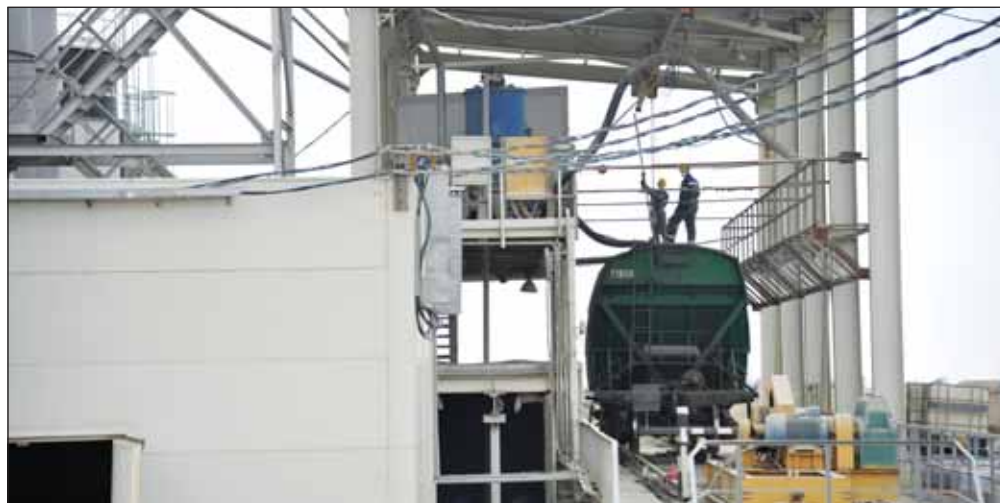
Строительство ГОКа по добыче и переработке калийных руд под Волгоградом
