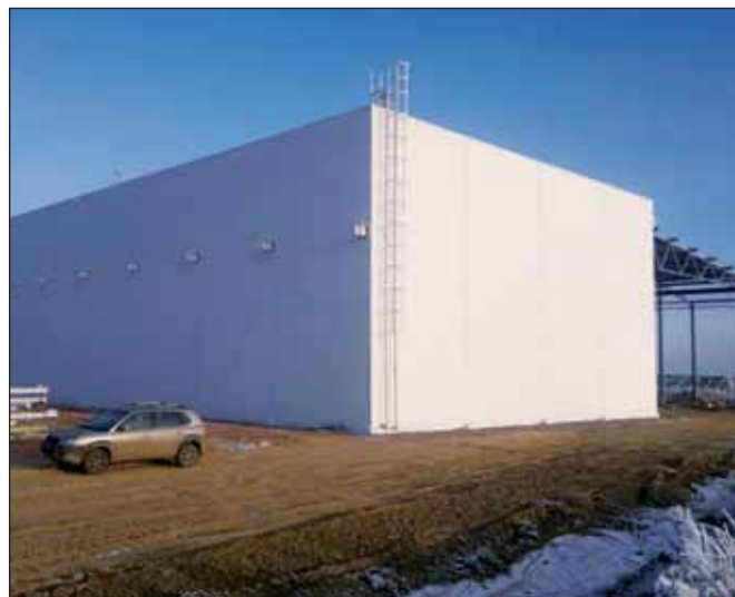
В качестве теплоизоляции производственного цеха используется кровельная система «Оптима», разработанная компанией «Пеноплэкс»
