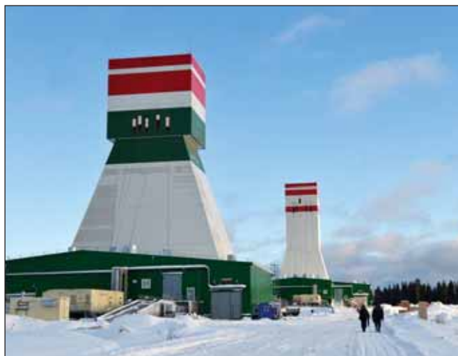
Строительная площадка ствлов Усть-Яйвинского рудника. «Уралкалий» в связи с аварией на шахте может ускорить ввод в строй новых добывающих мощностей на Усть-Яйвинском и Половодовском участках (рис. 1)
