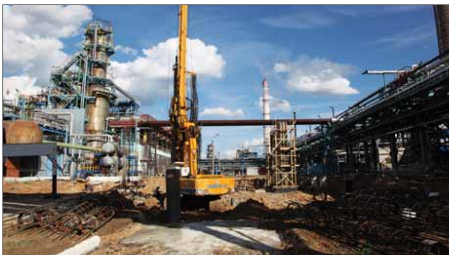
Стройплощадка новой двухкамерной пиролизной печи, ОАО «Казаньоргсинтез». Установка, запустить которую планируется в сентябре 2015 года, рассчитана на производство 135 тыс. т этилена в год
