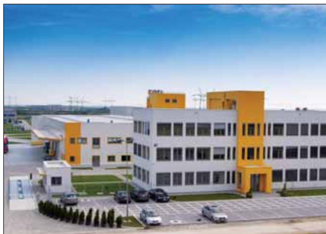
Новый производственный комплекс Sika, Шимановцы (Сербия)
