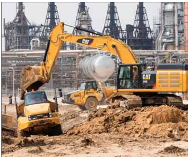
Строительная площадка ГХК компании ExxonMobil, штат Техас (США)
