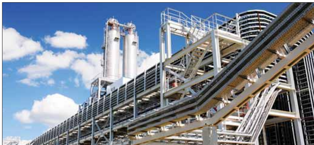
Завод полипропилена ООО «Полиом», Омск
