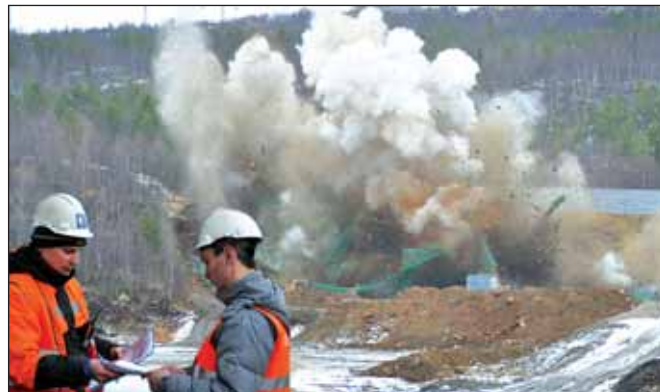
Австралийская корпорация «Орика» завершает строительство завода эмульсионных взрывчатых веществ в Мурманской области
