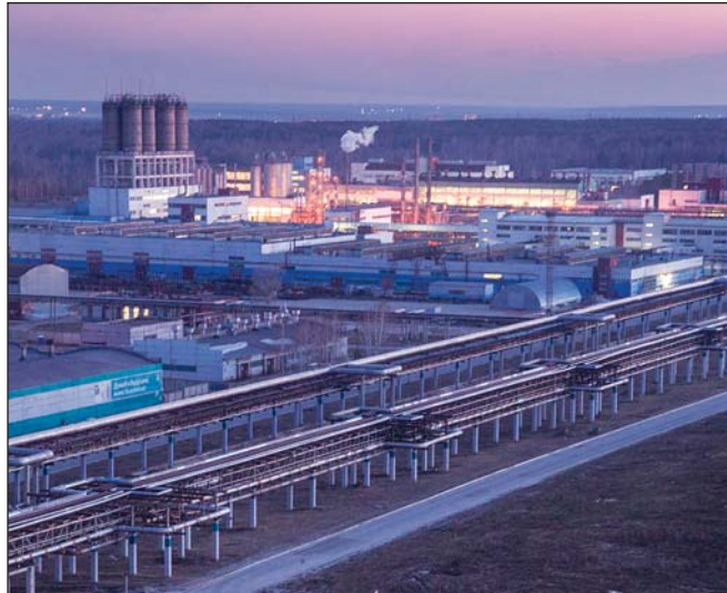
Производство полипропилена ООО «Томскнефтехим»
