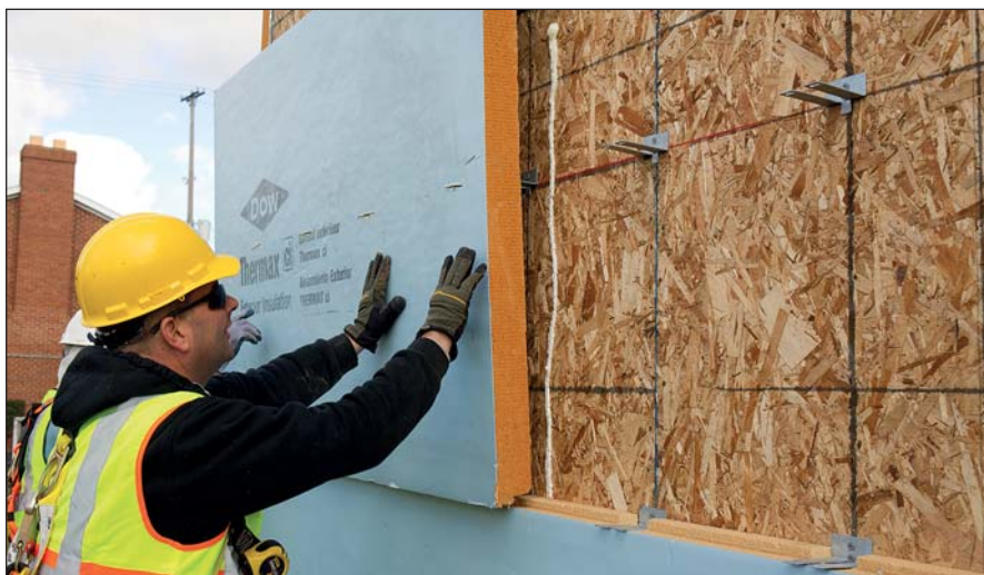
По теплоизолирующим свойствам 25 мм пенополиуретана приравняются к 18 см древесины или 51 см красного кирпича
