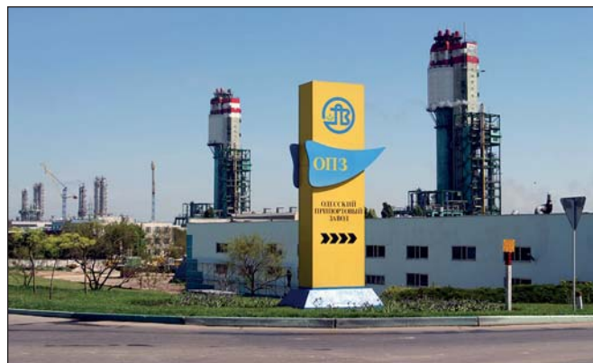
Одесский припортовый завод
