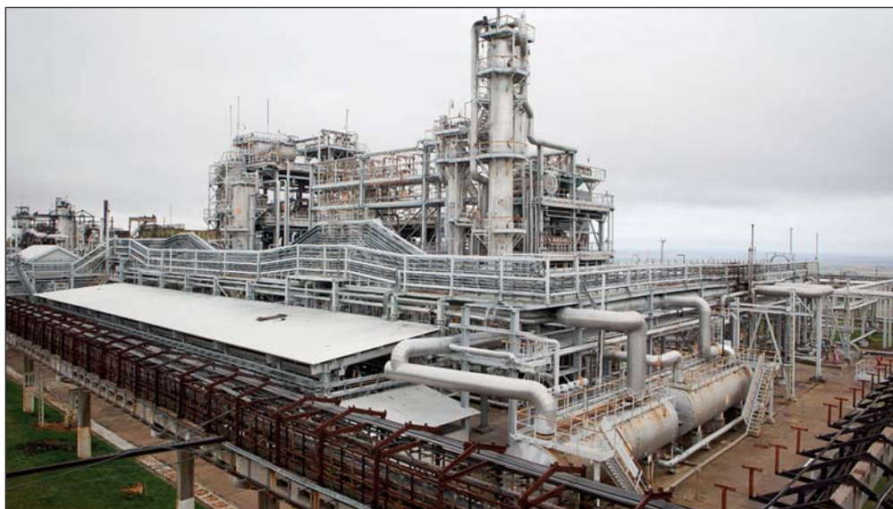
Нефтеперерабатывающий завод «Башнефть-Уфанефтехим»
