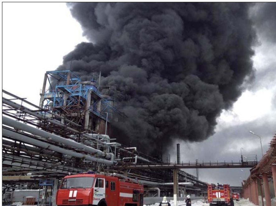
Пожар в результате взрыва колонны для переработки нефтепродуктов на заводе «Омский каучук», 6 марта 2014 года. Площадь пожара на предприятии составила 1000 кв. метров
