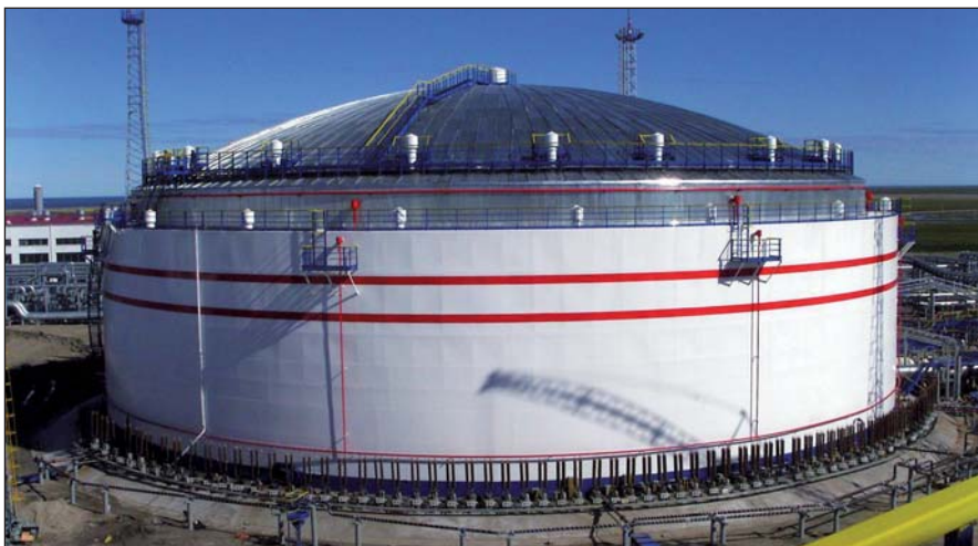
Типовой нефтеперерабатывающий завод мощностью 10–15 млн т в год сосредотачивает на своей промышленной площадке от 300 до 500 тыс. т углеводородного топлива, энергоемкость которого эквивалентна 3–5 Мт тротила
