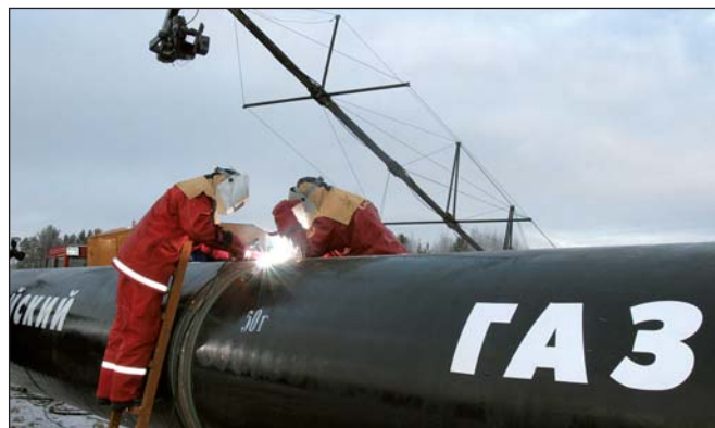
«Газпром» собирается выбрать участок газопровода, который станет полигоном для испытаний композитных труб
