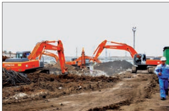
Строительство комплекса акриловой кислоты, Салават
