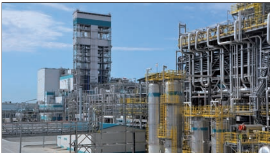
В октябре 2013 года был введен в эксплуатацию «Тобольск-Полимер» — крупнейший в Европе комплекс по производству полипропилена мощностью 500 тыс. т в год, сырьем для которого является пропилен, производимый из сжиженных углеводородных газов
