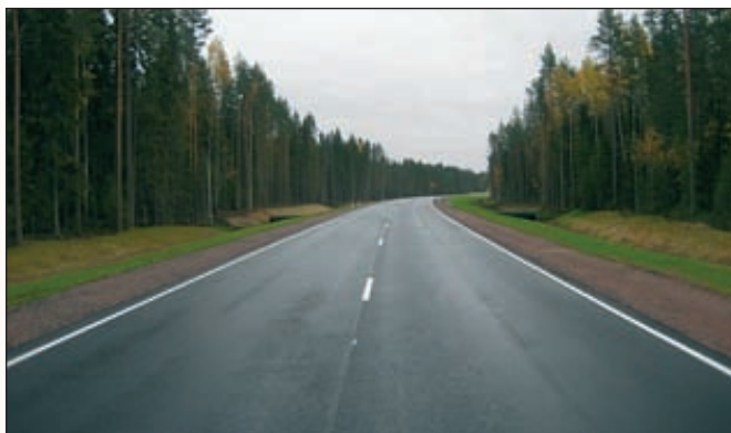
При участии «Сибура» и «Газпромнефти» был построен участок дороги с использованием геосинтетики и ПБВ на подъезде к пос. Тундрино в ХМАО
