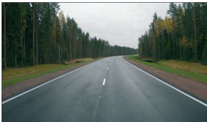
При участии «Сибура» и «Газпромнефти» был построен участок дороги с использованием геосинтетики и ПБВ на подъезде к пос. Тундрино в ХМАО
