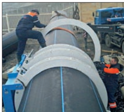
Глубоководный выпуск в Сочи (диаметр трубы 1600 мм)
