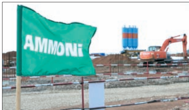
Строительство химзавода «Аммоний», Менделеевск
