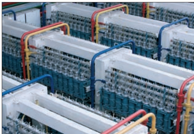
Завод разделения изотопов ОАО «Сибирский химический комбинат»
