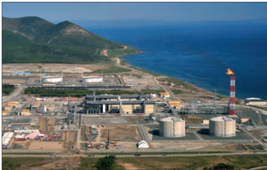
Завод СПГ на Сахалине
