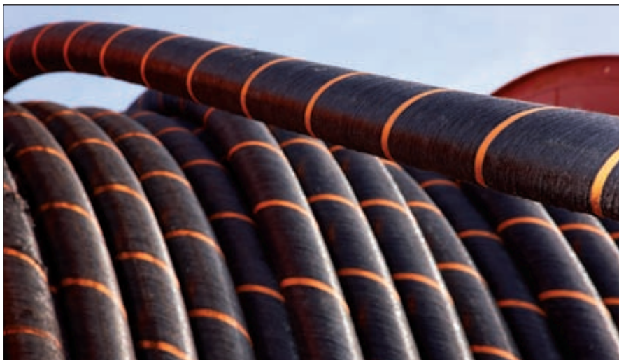
Изоляционные материалы торговой марки DOW ENDURANCE™ использовались для прокладки кабеля в Сочи и Краснодарском крае для Олимпийской инфраструктуры
