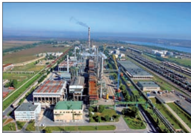
«Одесский припортовый завод»
